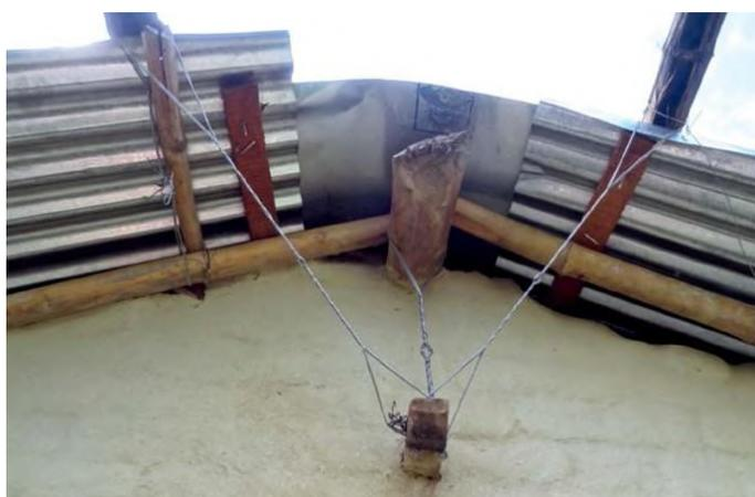
Ataduras improvisadas con alambre para asegurar las láminas de zinc y las vigas a la pared (IFRC-SRU).
