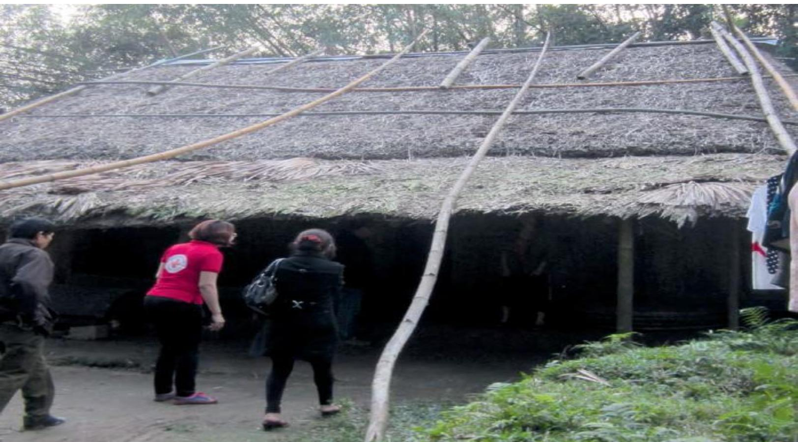
Vietnam, ciclón Nari, 2013: se ha colocado troncos de bambú sobre la cubierta del techo para mantenerla em su sitio (© Shelter over head).
