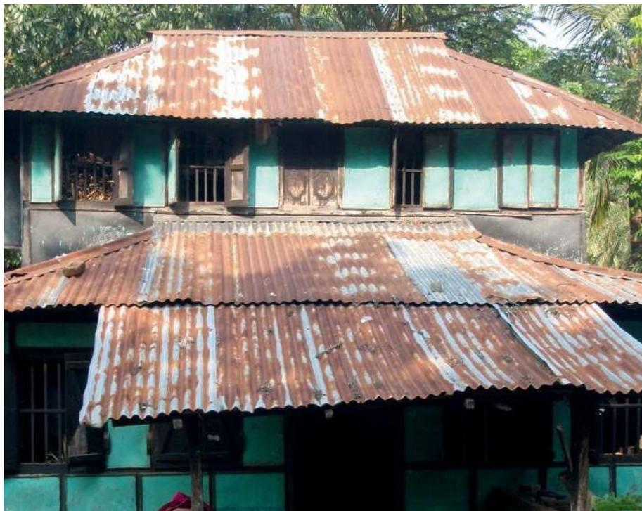
Zona costera en Kalapata, Bangladesh: chapa ondulada de hierro galvanizado afectada por la corrosión (IFRC-SRU).
