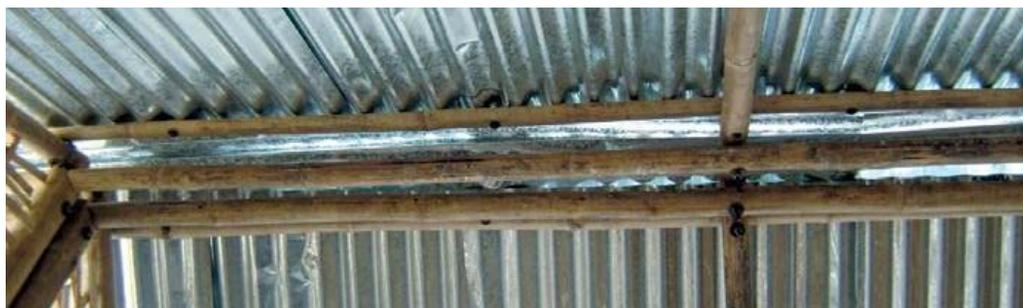
Nepal: láminas de zinc sujetas con pernos a una estructura de bambú (IFRC-SRU).
