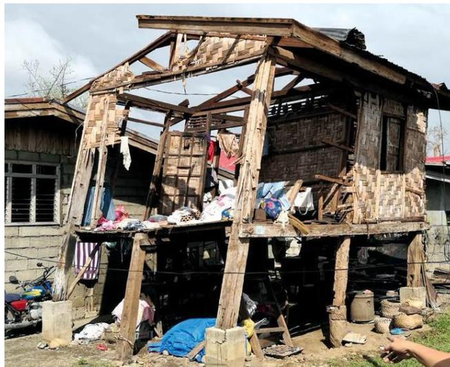
Las Filipinas: deslizamiento de una vivienda tras el paso del tifón Haima, 2016. (Ver el efecto de deslizamiento en la Sección C.1). (IFRC-SRU).
