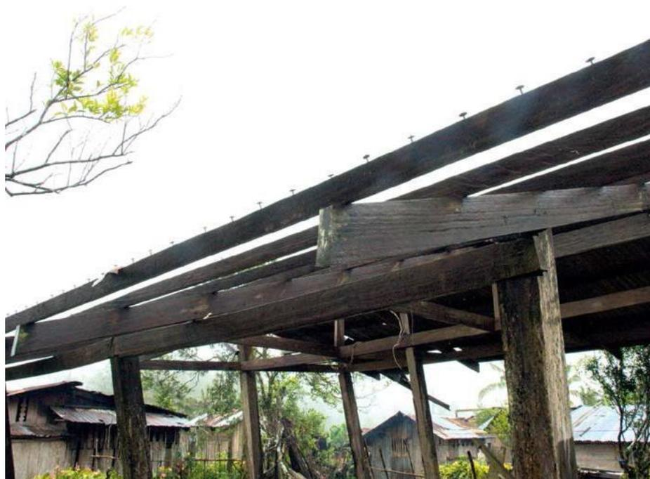
Filipinas: Estructura del techo de la que se soltaron las chapas onduladas de hierro galvanizado (IFRC-SRU)
