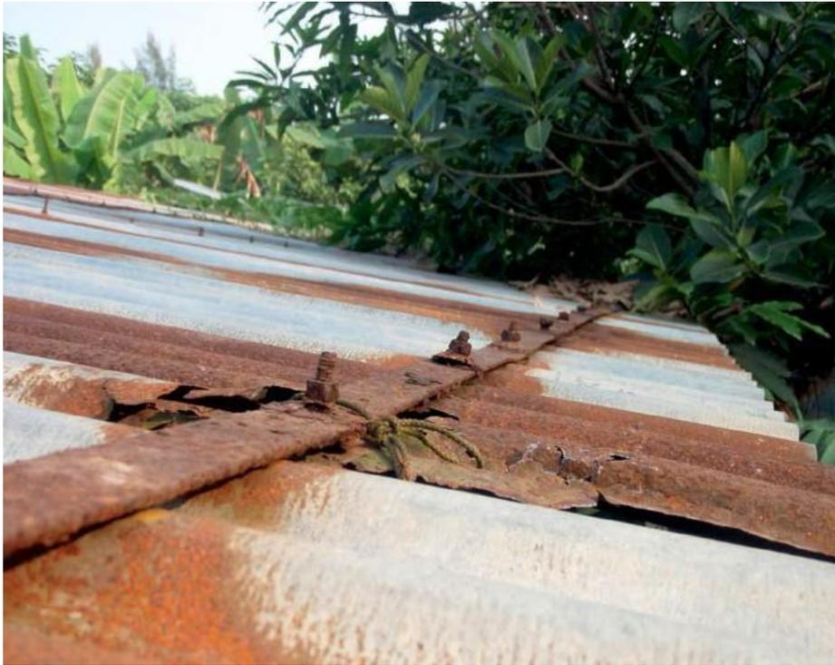
Corrosión galvánica de la lámina, vigas y pernos (IFRC-SRU).
