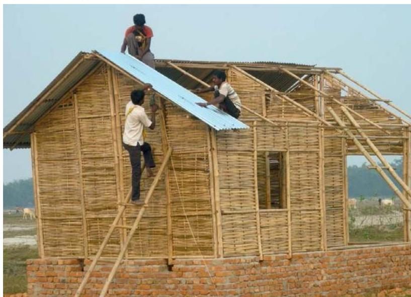
Nepal: instalación de una lámina de zinc sobre una estructura de bambú (IFRC-SRU).
