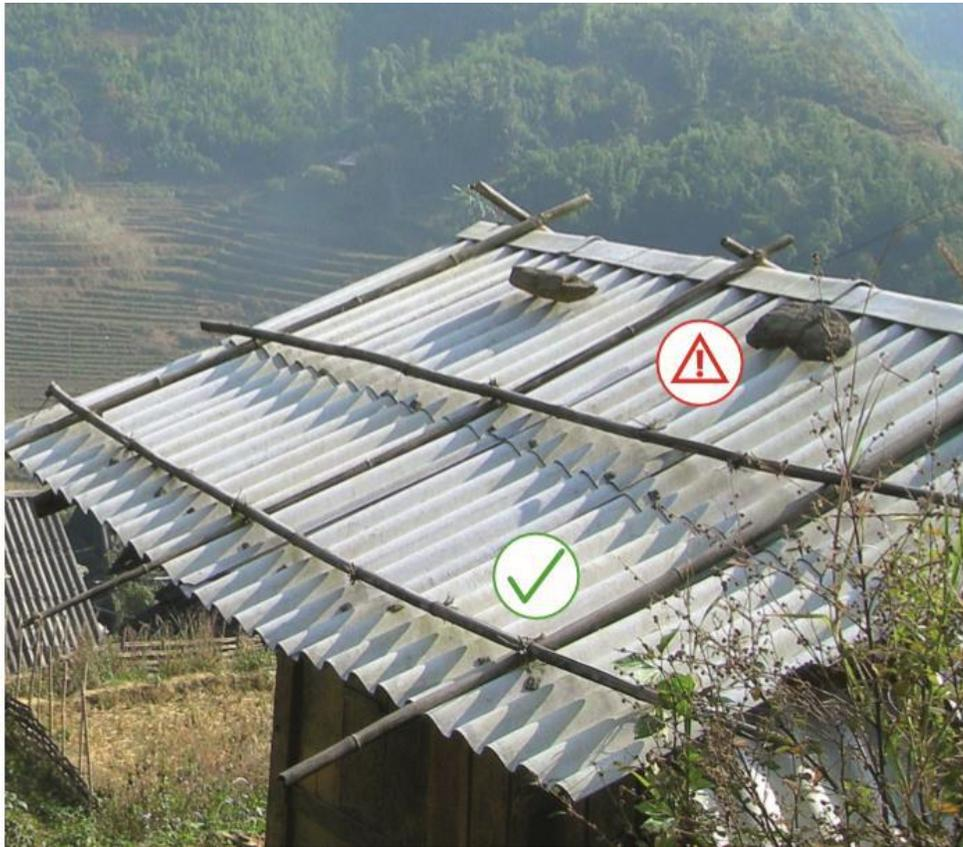
Vietnam, 2006: palos de bambú colocados sobre un techo a dos aguas para protegerlo del levantamiento. No se recomienda colocar piedras sobre los techos de lámina de zinc (© Cruz Roja Holandesa).
